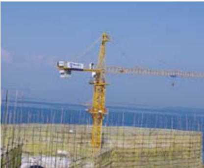
建设中的项目
