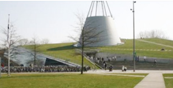
图七 绿色屋顶——荷兰代尔夫特图书馆。具有绝缘性能、冷却系统更佳，吸音性能更强的优点。绿色屋顶还提供了雨水积池的便利条件。
