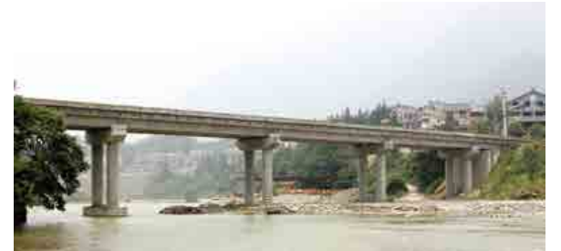
2010 年 7 月 6 日虹口高原大桥项目
