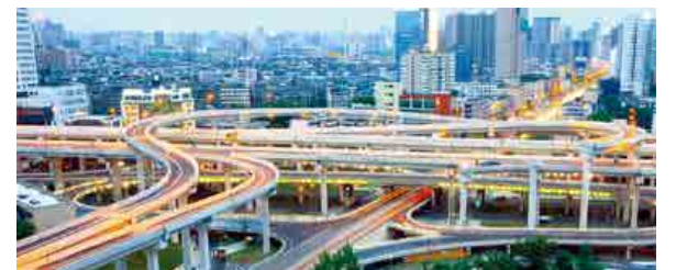
成都市二环路工程
