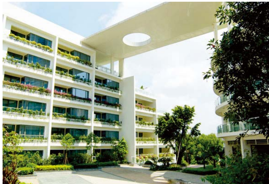
招商地产泰格公寓 - 中国首个获得LEED银级认证的商业项目
