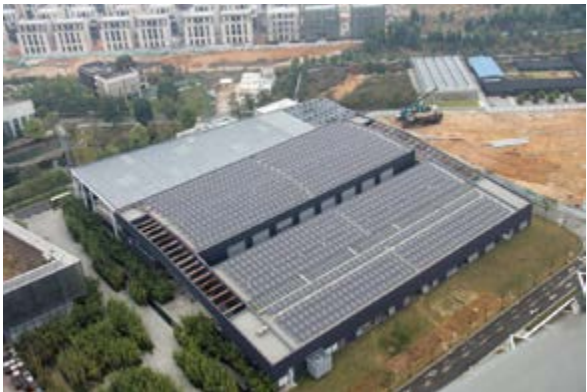
实验塔顶鸟瞰图、屋顶光伏太阳能
