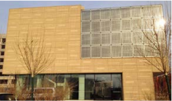
2号能源站—采用循环利用的建材外墙和光伏太阳能外墙
