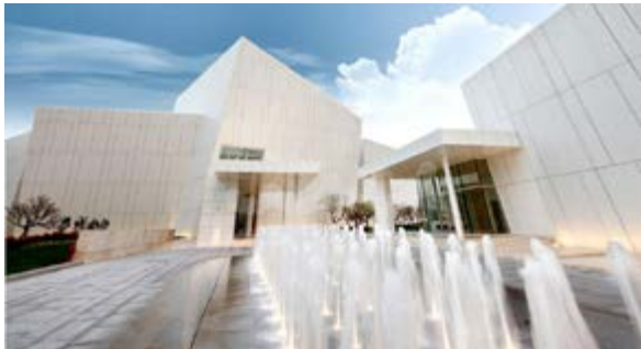
世界建筑巨匠理查德·迈耶杰作——华会所
