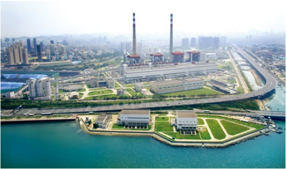
华电青岛发电有限公司 Huadian Qingdao Power Corporation
