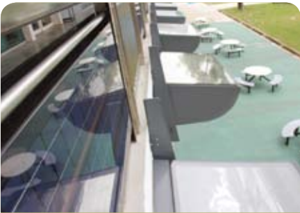
装在窗外用来反射日光入户的装置，减少照明能耗
