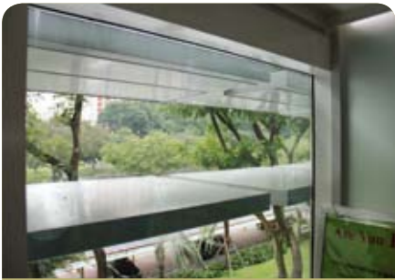
装在窗外用来反射日光的平板，减少照明能耗
