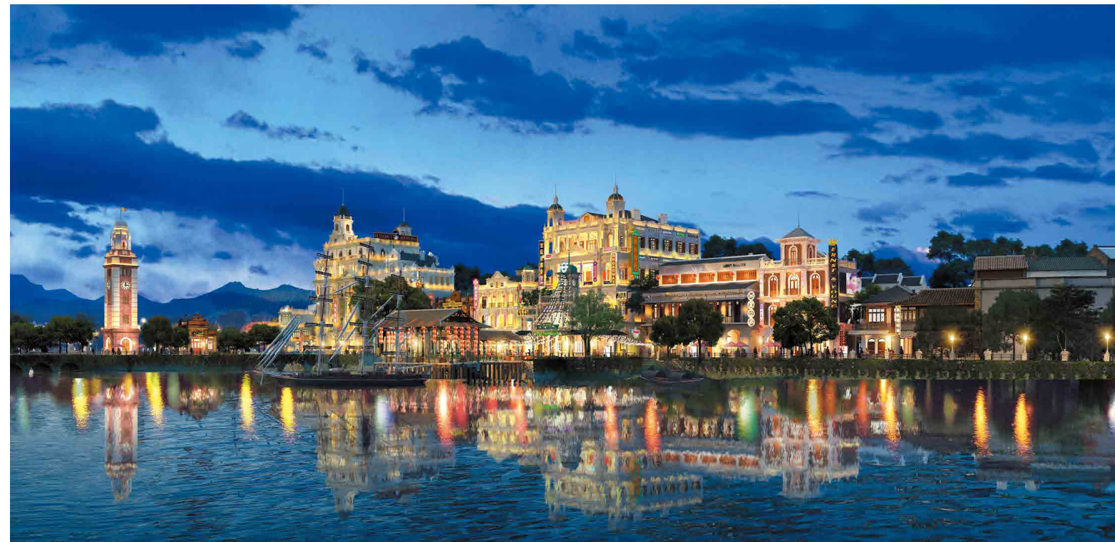
海口观澜湖南洋街建筑
