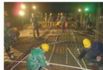
2009年8月，水磨中学建设施工工人们昼夜奋战的场景
