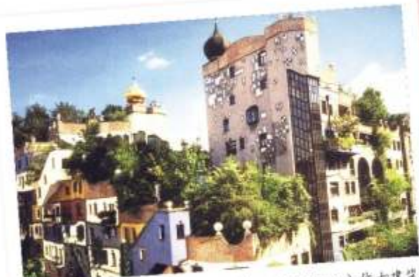
维也纳汉德瓦萨(Freidensreich Hundertwasser)仿古建筑
