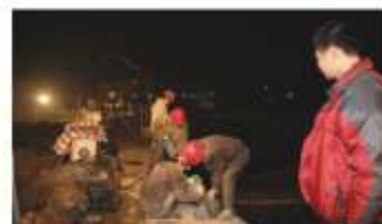
2009年11月18日，寿溪湖施工现场凌晨1点仍在施工。
