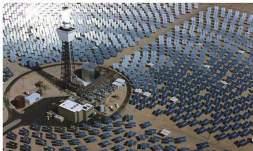
图为某大型太阳能聚热发电站
