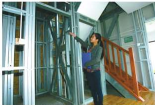
重庆首家低碳房亮相大学城，轻型钢撑起了整座房子的结构
