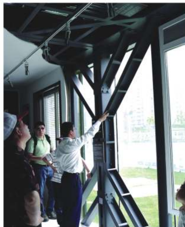
远大抗震科技体验馆的内部支撑钢架结构（图片由远大提供）
